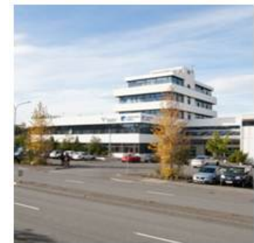
Kringlan 1 var byggð í tveimur áföngum á árunum 1983-1991. Húsið er leigt til opinberra aðila.
