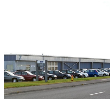
Skútuvogur 7 hýsir innkaupa- og dreifingarmiðstöð Aðfanga og er húsnæðið útbúið sem slíkt.
